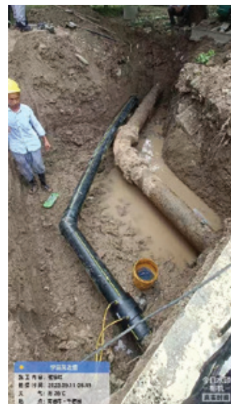
圖 南通大眾燃氣燃氣管網改造現場
