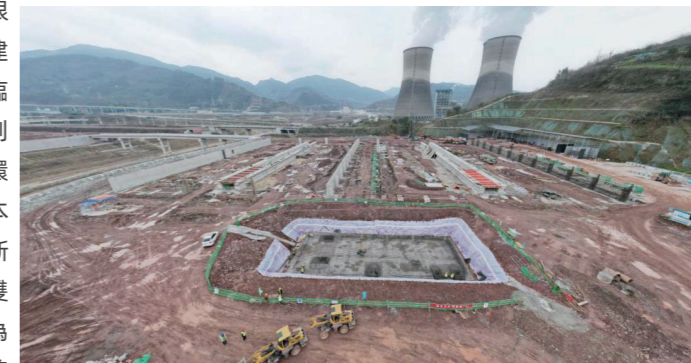
推進萬州港區建設
