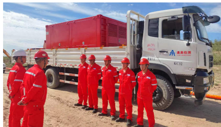
寧夏鹽池 CCUS 項目氣密封檢測作業現場
