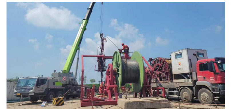
安東完成世界首例光纖監測技術在地熱 U 型井中的應用，為客戶地熱能可再生能源開採提供數據支持
