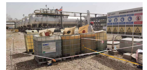
在 CPF 站區設置回收區，污油回收不落地，實現資源再利用
