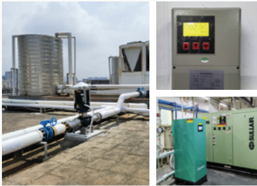
高效能源生產：惠州工廠利用空氣壓縮機和光伏產生的廢氣來減少排放
