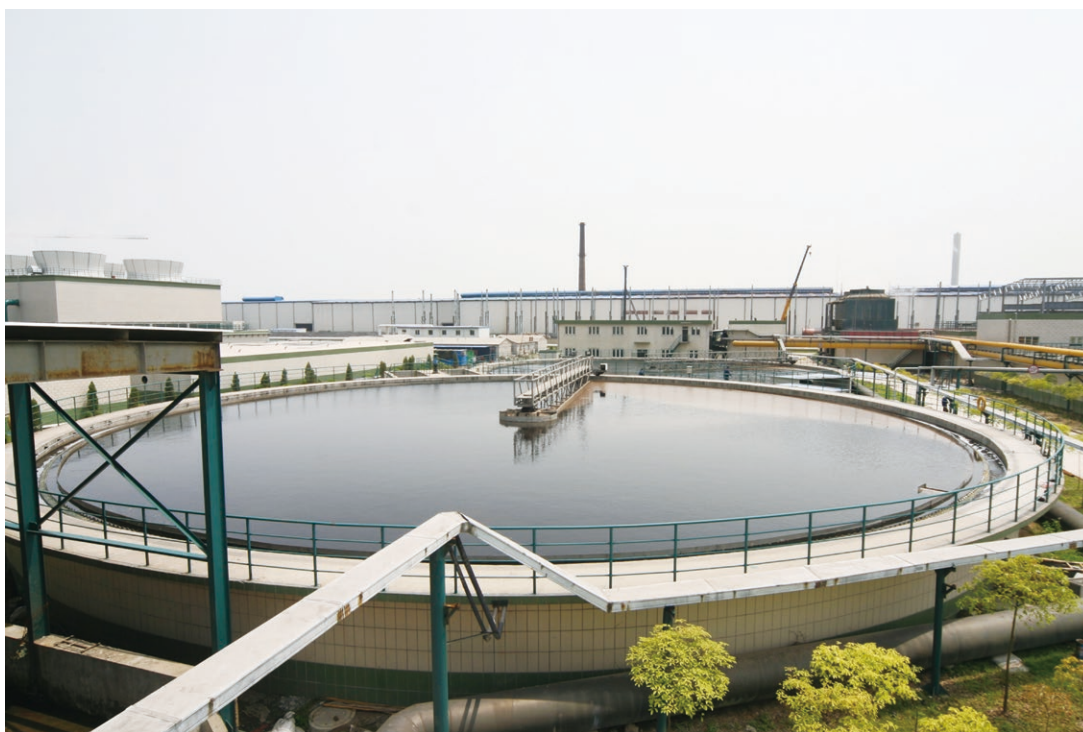
Sewage treatment station 污水處理站
