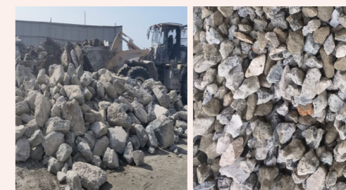
混凝土骨料来自回收建筑垃圾
