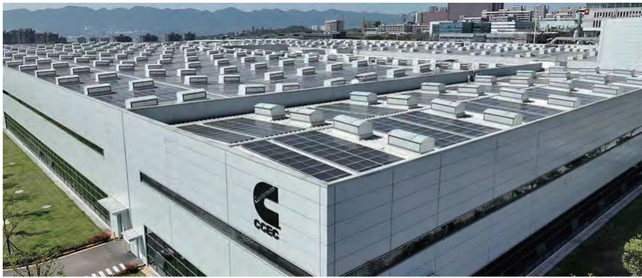
Photovoltaic Project of Chongqing Cummins 重慶康明斯光伏項目
