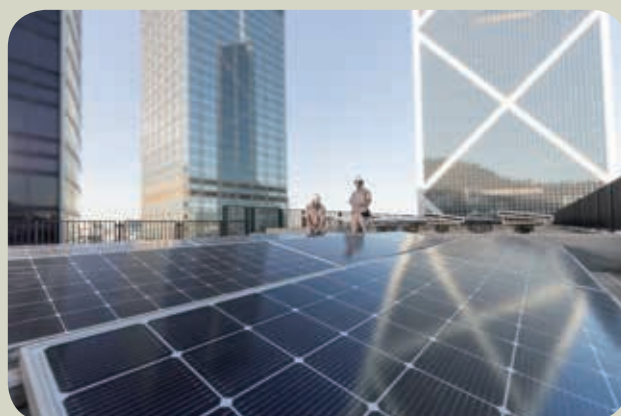
在花園道三號安裝太陽能光伏板
