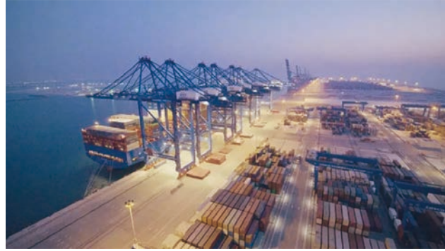
CSP阿布扎比碼頭在設計施工階段積極實施照明節能改造與智能控制，將照明燈具進行節能替換。
