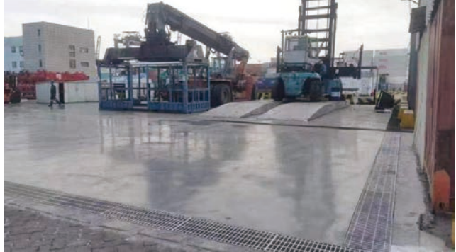
廈門遠海碼頭利用廢水回收設備，對車輛沖洗後的廢水進行收集、沉澱後再重複利用。
