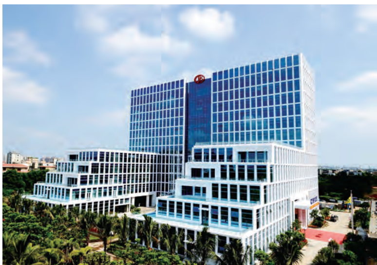
由常宏設計施工的中冀建勘海南辦公樓外裝幕牆項目，已成為海口市江東新區邁雅濱河商務區標誌性建築
