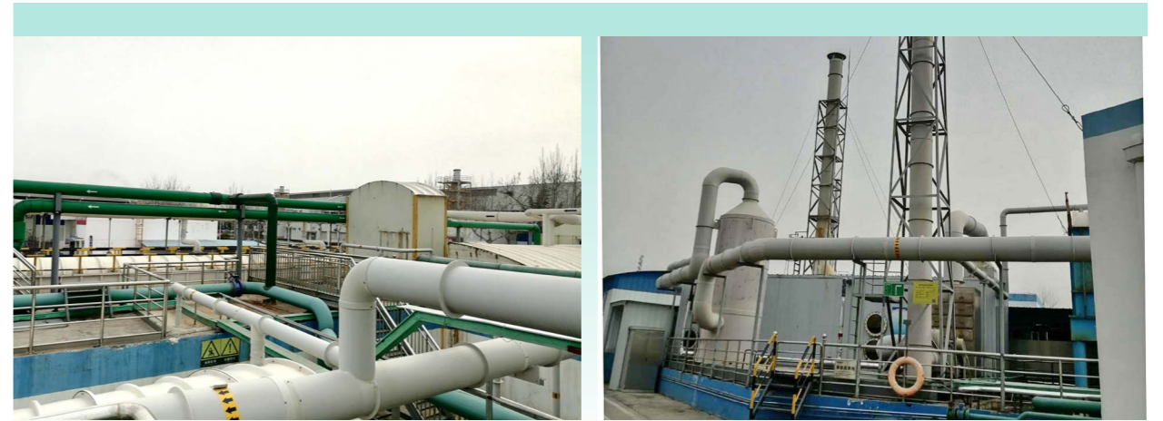
對高新園區污水站惡臭氣體進行收集和治理，確保污水站無惡臭氣體逸散
