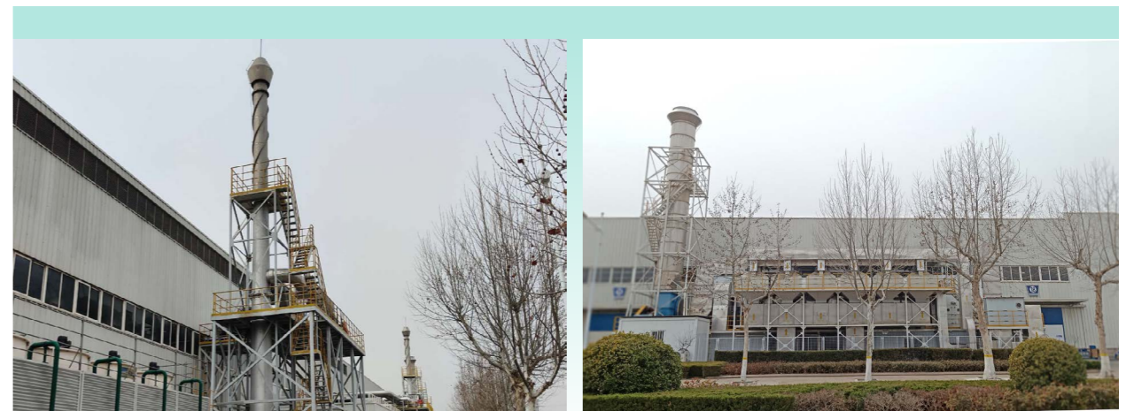
完成試車廢氣治理設施的建設及投用
