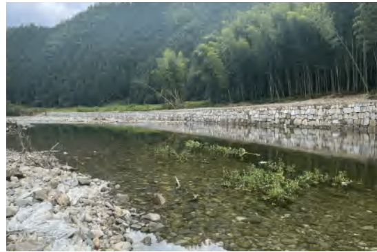
率水流域生態環境修復項目 - 修復後
