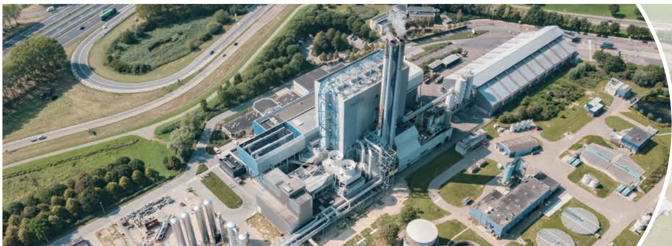
AVR 位於荷蘭杜伊文的轉廢為能設施收集二氧化碳，並供應給當地的溫室種植行業。
