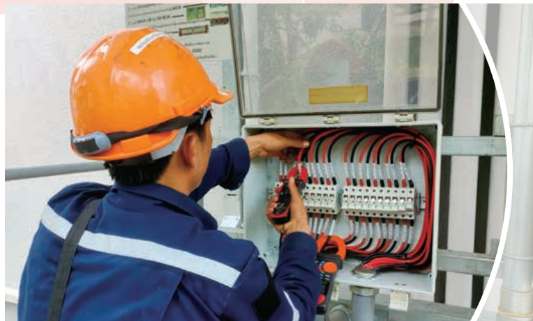
RPCL的工作人員在一棟行政大樓檢查天台太陽能系統的預防性熔絲裝置。
