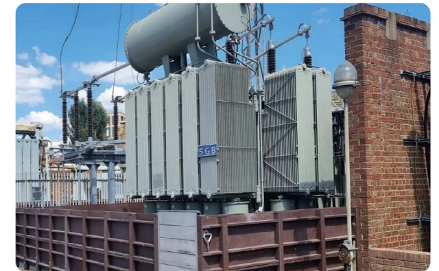
UKPN在旺德爾(Wandle)河畔建立永久防洪設施，以防發生千年一遇的洪水事件。
