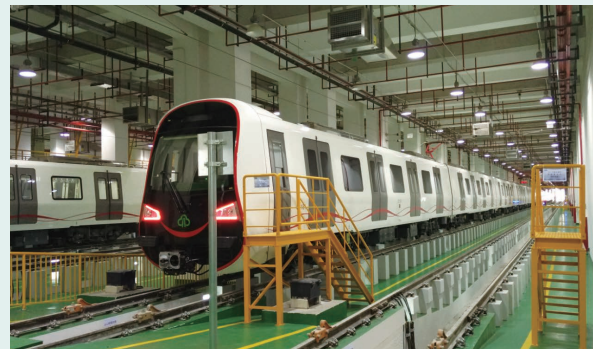
圖：福州地鐵新店車輛段現場
