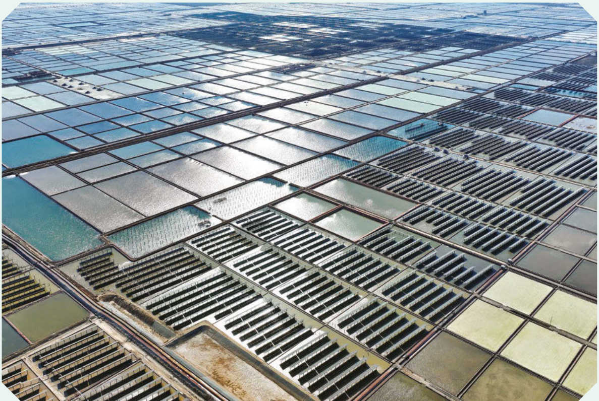
華能山東山鹽150兆瓦光伏發電項目
