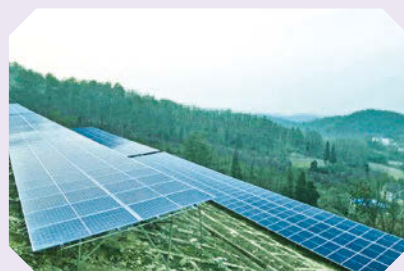
華能湖北分公司建設高家溝村屋頂光伏
