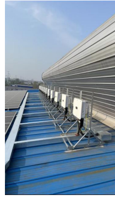
光伏項目實施改善前
