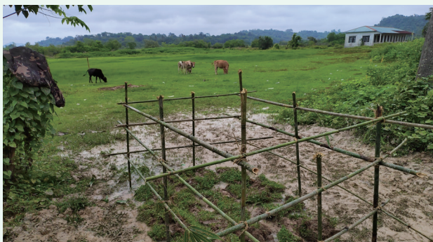
中信建設對陸域探坑進行生態修復
