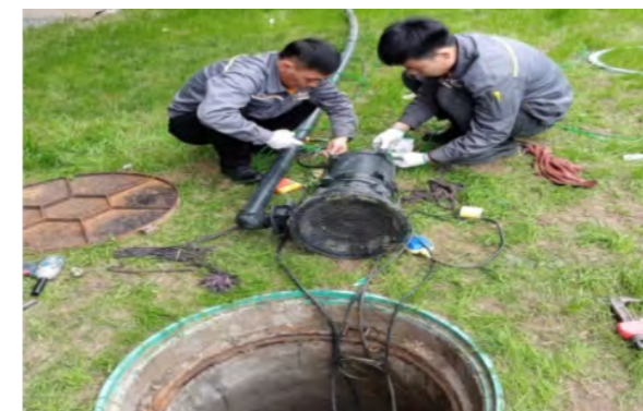
▲ 工作人員對雨水回收系統進行檢修改造 Workers revamping the rainwater recycling system
