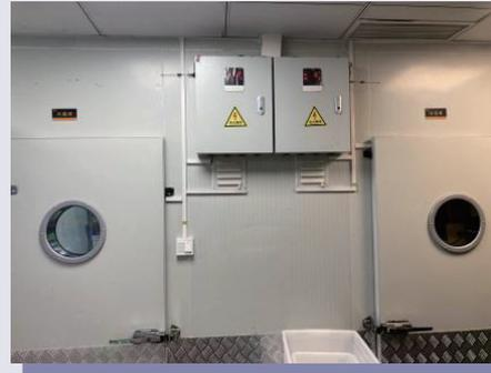
增加冷庫智能控制箱和設備後，冷庫平均每天耗電量降低約1/3即27-30度左右，預計一個冷凍庫全年可節電4,000度左右。
