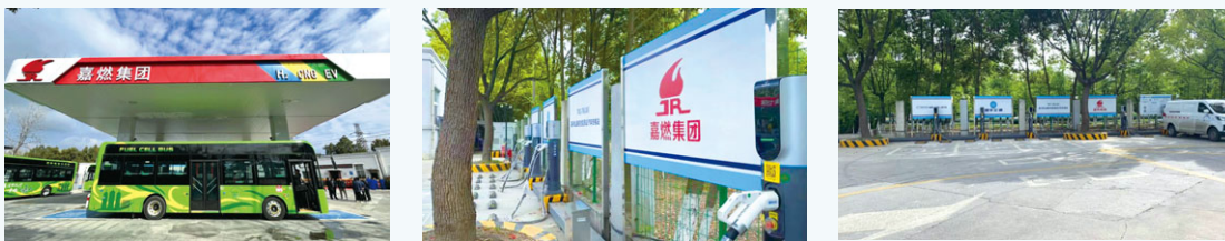
圖：崗山路綜合能源站
