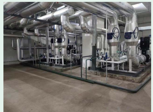
熱力站內改造
