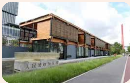
智慧城市成功中標楊浦濱江智慧管理平台
