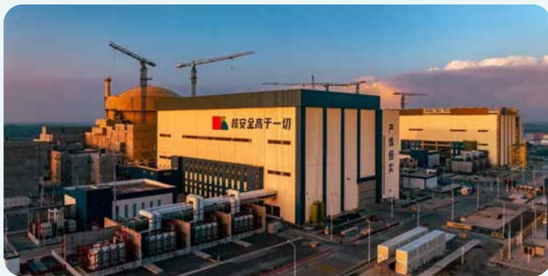
“華龍一號”防城港 3 號機組併網發電
