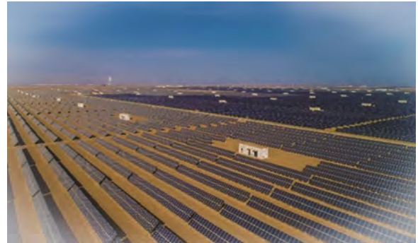
◆ 戈壁灘上風光好，敦煌市某光伏發電項目進入「加速跑道」
