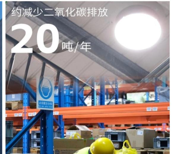
这个独特的圆形罩，通过捕捉室外的自然光线，经由高精度的导光管传输，营造出比传统照明更为自然、舒适的室内光环境。在泉峰新能源工业园，这样的日光照明系统共设置了66套，每年可节约3.5万kwh的电能，减少二氧化碳排放20吨/年。
