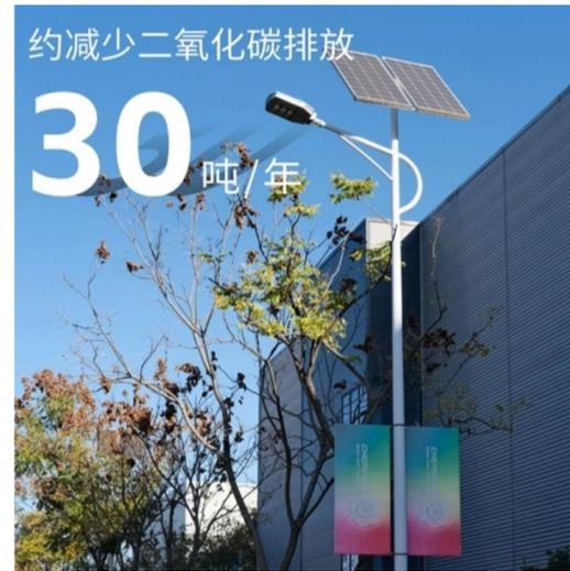
太阳能路灯白天将阳光转化为电能，并储存于蓄电池组中。夜晚，蓄电池组释放储存的能量，为LED灯光源提供源源不断的电力。这样的太阳能路灯在泉峰新能源工业园共有154盏，每年这些路灯可节约5.2万kwh的电能，减少二氧化碳排放30吨。
