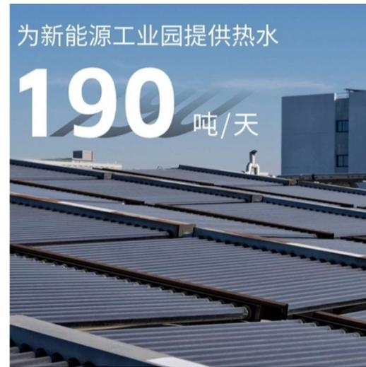
泉峰新能源工业园通过使用太阳能技术，为食堂和宿舍楼提供可持续的热水解决方案。整个园区共铺设9,400根太阳能集热管。每天，这些集热管可以提供190吨热水，为员工带来舒适的生活体验。
