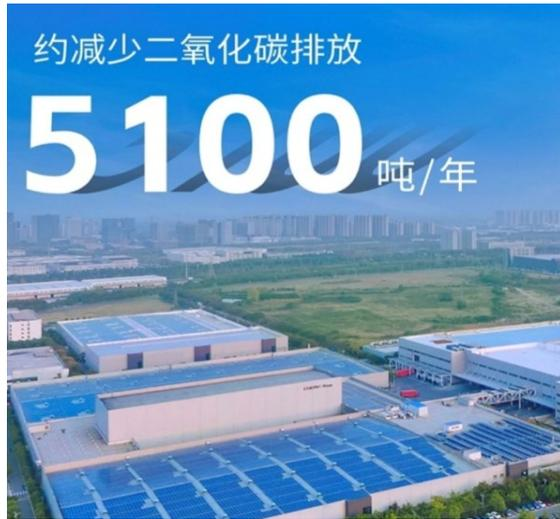
泉峰新能源工业园屋顶有面积超过54,800m<sup>2</sup>的光伏组件，形成颇具规模的屋顶太阳能光伏电站。自2014年首次引入这一绿色能源技术以来，泉峰已建成屋顶太阳能光伏电站装机容量超过10.6MWp，每年可产生超过900万kwh清洁电能，减少排放二氧化碳5,100吨。
