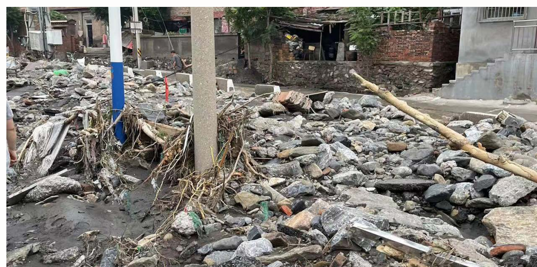
洪災過後受損嚴重的基礎設施
