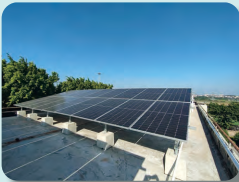
光伏發電項目鋪設
