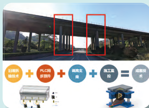
北二環下穿華南快速主線橋採用整體拼寬的倒L墩置換方案
