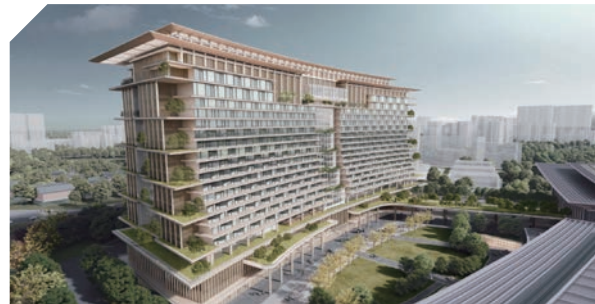
Shenzhen International Exchange Centre 深圳國際交流中心
