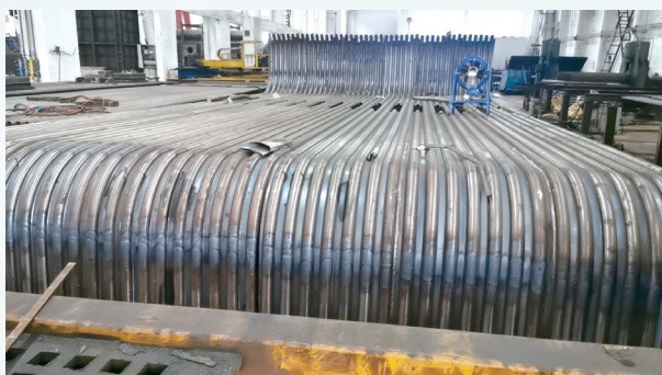
水冷壁現場裝配
