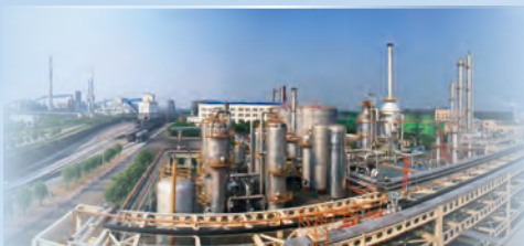
3 | Dingzhou, Hebei 河北定州
