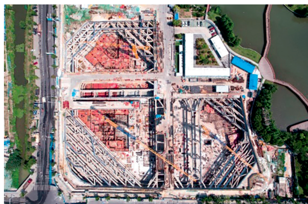
砗對撐基坑支護
