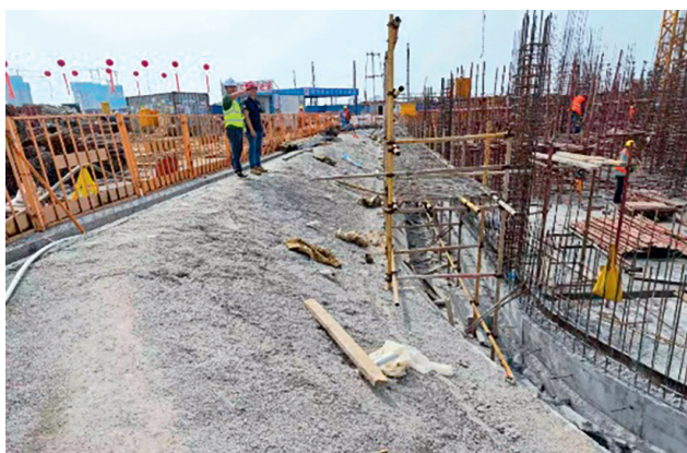
噴錨基坑支護
