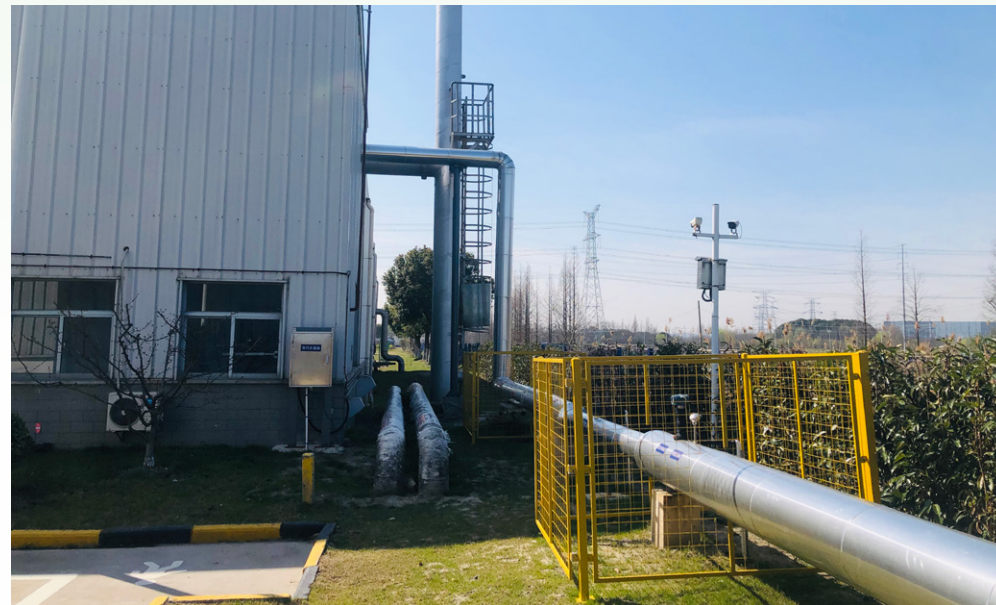
市政蒸汽管道已鋪設完成
