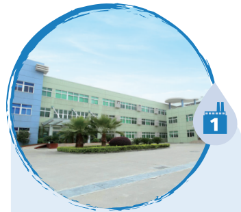
位於廣東中山的油墨廠房 The inks plant in Zhongshan, Guangdong
