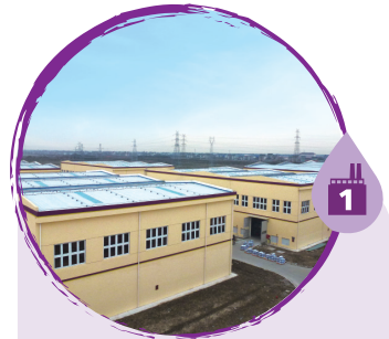
位於上海金山的塗料廠房 The coatings plant in Jinshan, Shanghai
