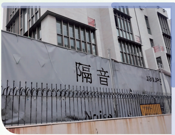
Noise barriers are installed onsite to control noise 在地盤使用隔音圍板控制噪音
