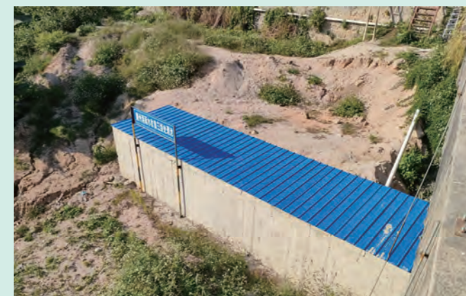
肇慶康州港利用碼頭內的雨水收集系統，收集水用於園林綠化或壓制灰塵，節約水資源。
