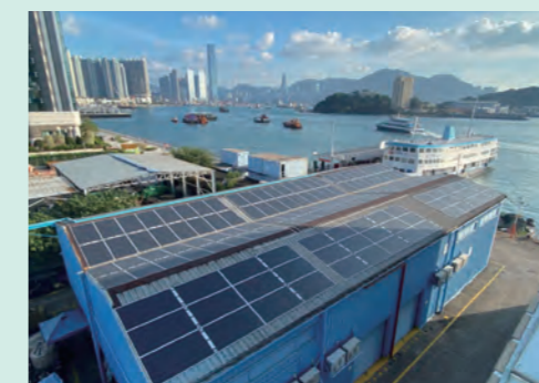
新渡輪共安裝了 323 塊太陽能板，總容量 109.85 千瓦，分別分佈在辦公大樓和兩個倉庫的屋頂。這些太陽能板每月平均發電 10,200 千瓦時，並出售給中國電力公司。
