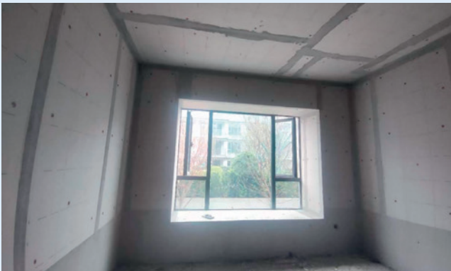
▲ 長沙麓溪雲境項目外牆內保溫系統
