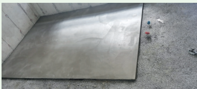
▲ 樓地面隔音塗料工藝
