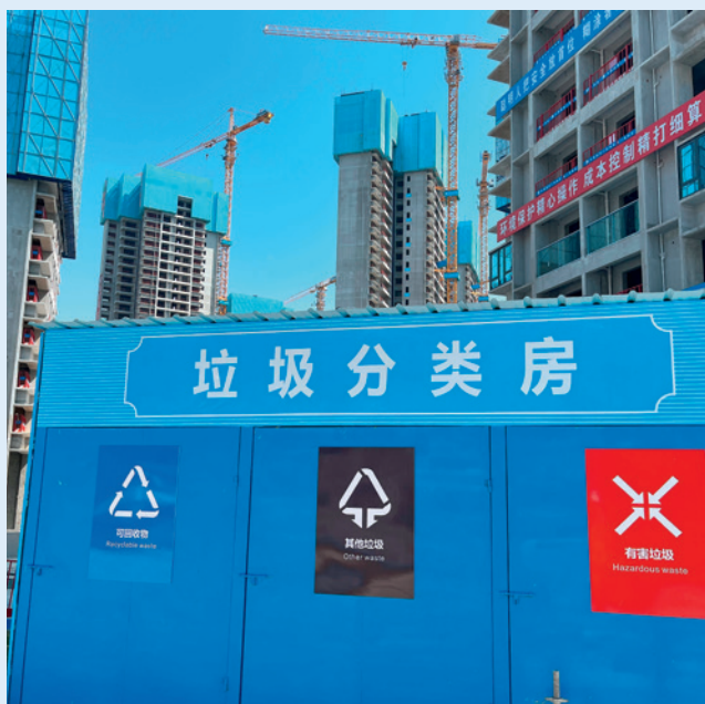
▲ 施工現場分類垃圾房
