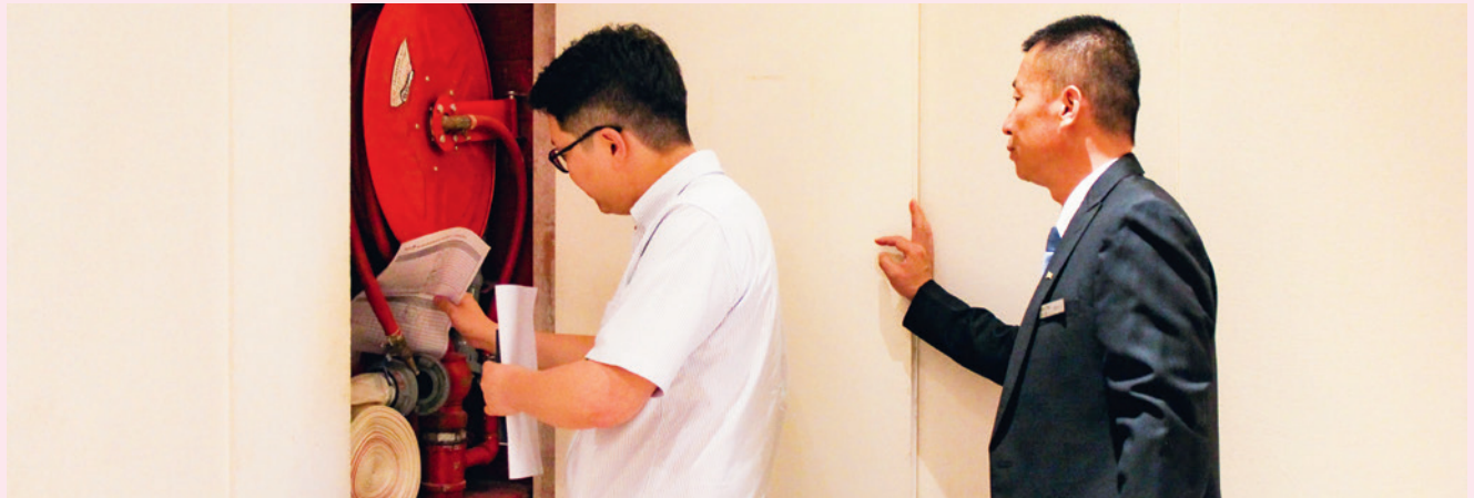
▲ 商管公司消防安全整治
