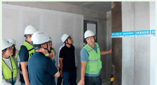
▲ 品控小組把控施工
