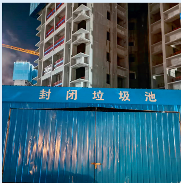
▲ 施工現場封闭垃圾池
