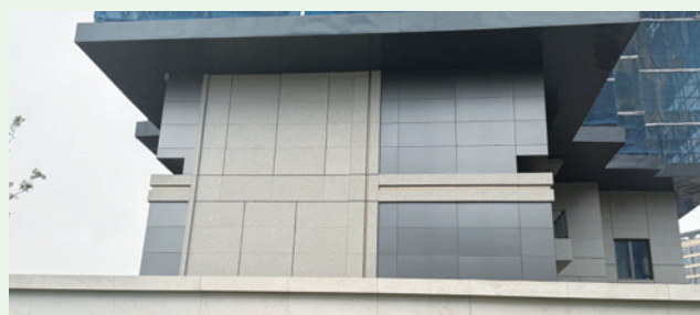
▲ 深安上居展示區真石漆外立面
