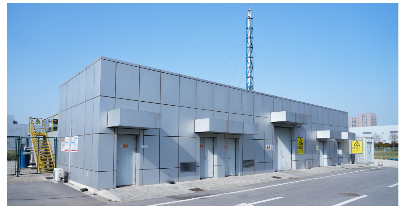
危廢貯存倉庫
