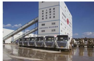
噪聲控制生產系統、皮帶封閉
