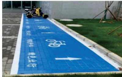
社區服務基礎設施設備提升
