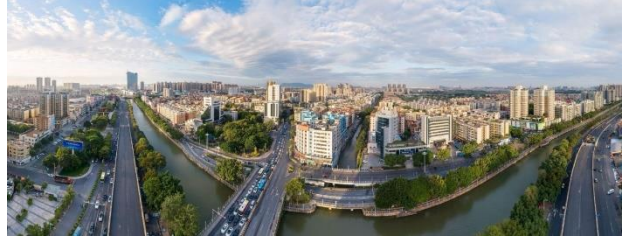
佛山市順德區樂從鎮城市水域治理
