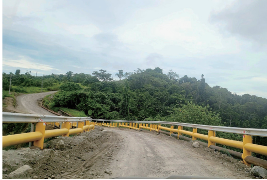
降坡路面改造
