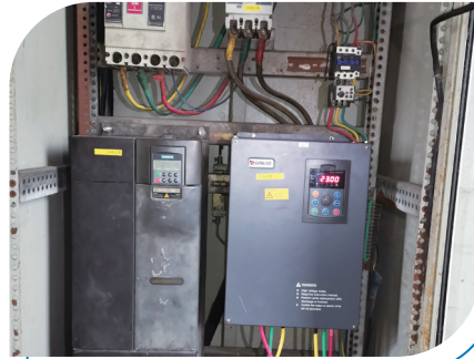
動力車間中水處理產品水泵變頻改造
