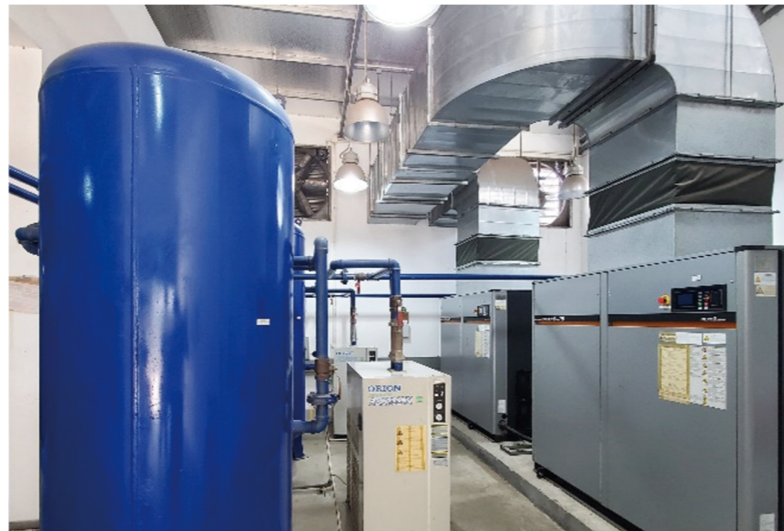
我們將為工廠設備，如空壓機安裝變速驅動器等長期能源效益措施。
