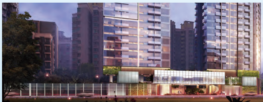
香港元朗十八鄉路項目 Hong Kong Yuen Long Shap Pat Heung Road Project
