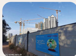
工地降塵噴淋設施
