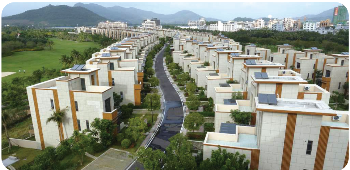
海南清水灣3號安裝太陽能系統
