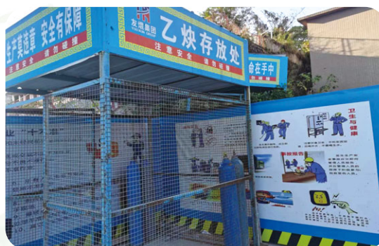
易燃、可燃材料堆放區域
