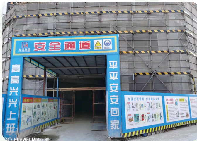
施工安全通道
