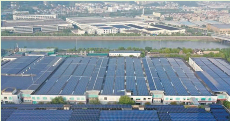
光伏發電系統
