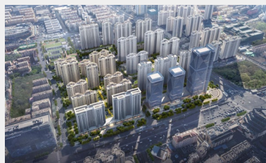
五里牌坊改造後城市面貌
