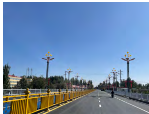
英吉沙县标志性帮扶项目——中交大道项目建成通车
