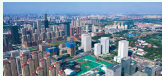
天津河西陈塘土壤修复项目 Tianjin Hexi Chentang Soil Remediation Project
