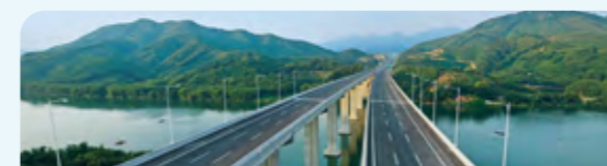
乐昌至广州高速公路 Lechang-Guangzhou Expressway
