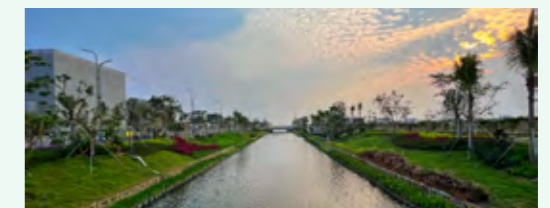
三亚崖州湾科技城水系工程项目 Yazhou Bay Science City Water System Project, Sanya
