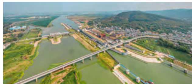
引江济淮一期工程江淮沟通段
