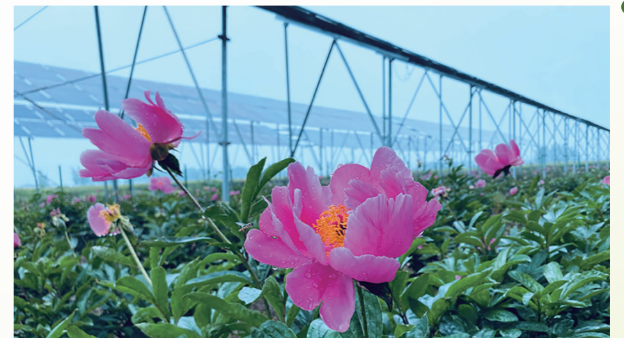
亳州(藥材種植)光伏電站
