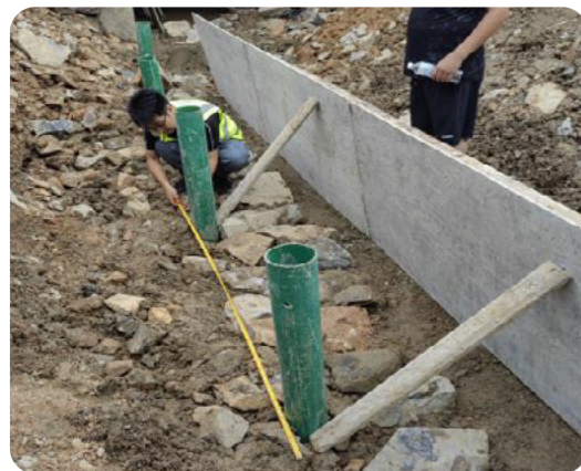
廢舊護欄用於邊坡支撐防護
