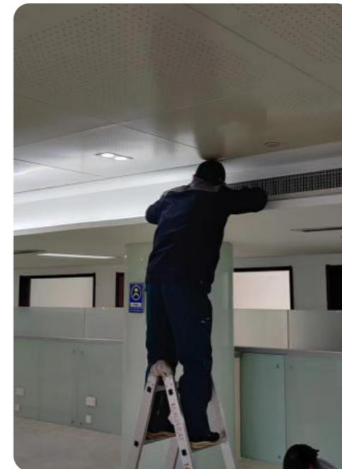
施工人員更換節能燈具
