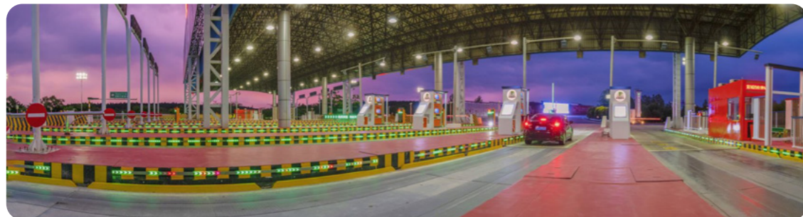
宣城西智慧收費站建設
